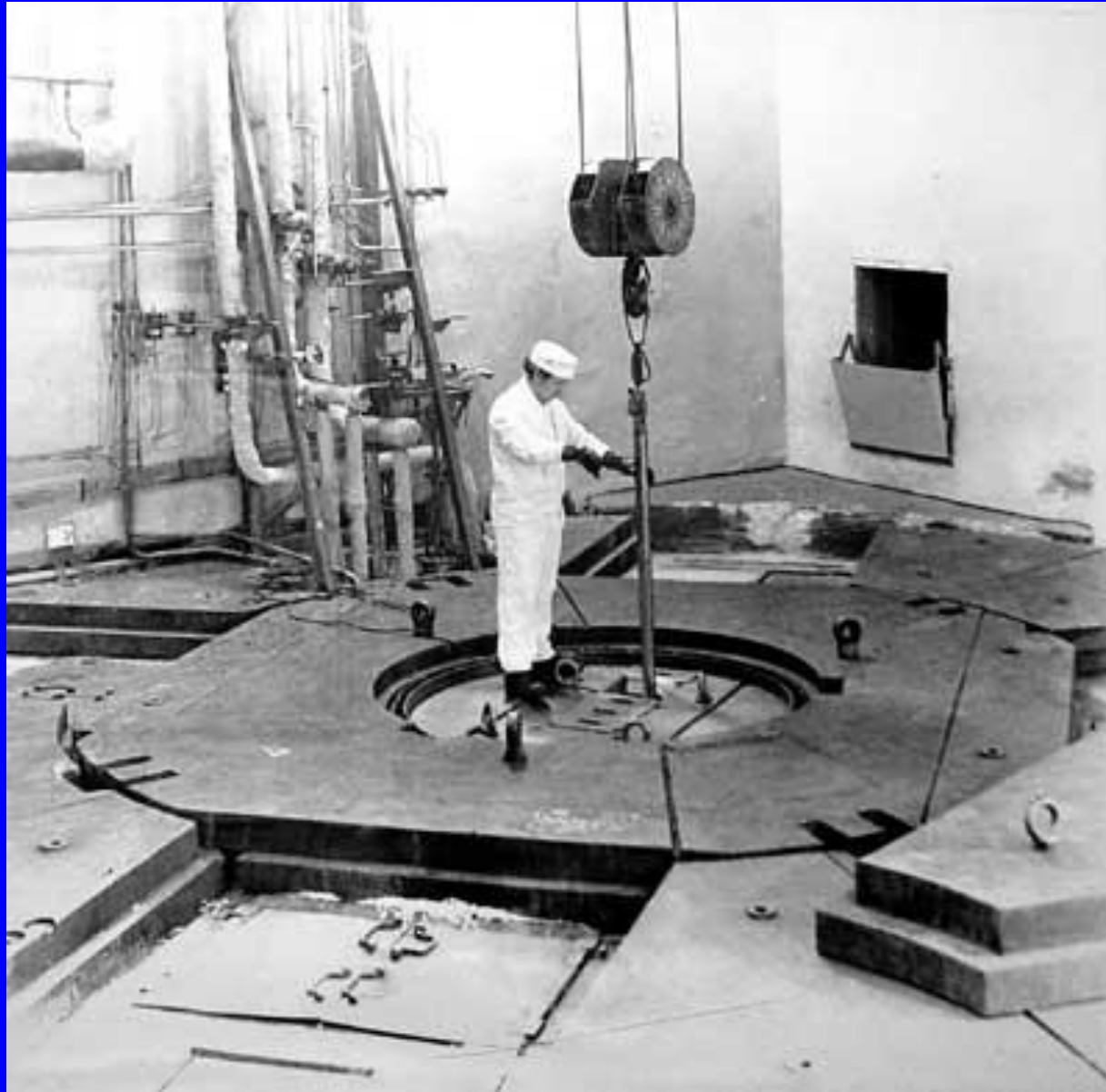
РЕАКТОР АМ-1 «АТОМ МИРНЫЙ» МОЩНОСТЬ 5 МВт
